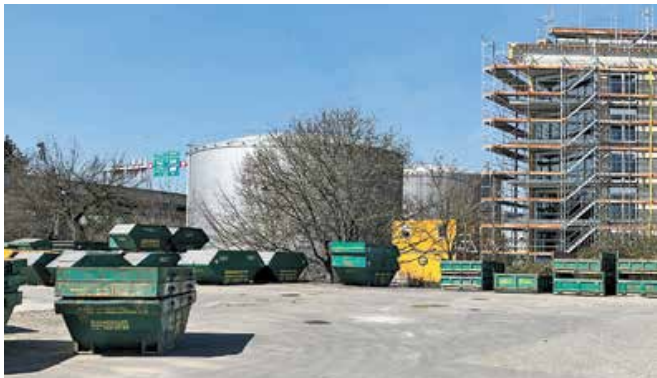
Noch ist nicht klar, was mit dem Tank-Areal in Weyermannshaus-Ost geschieht. (Bild: Fred Braune)
